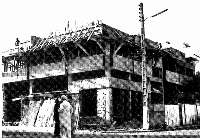
Bild 10. Investition im Geschäftsbereich. In jüngster Zeit wird alte Bausubstanz in zentraler Lage abgerissen und durch neue ersetzt. Die Investoren stammen vorzugsweise aus den größten Städten des Landes. Bauherr ist hier ein Advokat aus Fès. (Aufnahme: April 1980)
