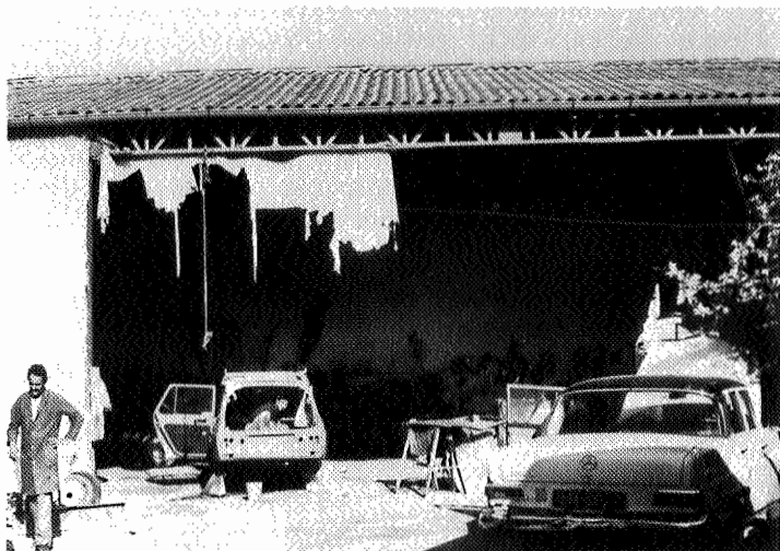
Bild 11. Lagerhalle im Block III, 12. Das Grundstück, über das besitzrechtlich noch Ausländer verfügen, wird bereits von Marokkanern in extensiver Weise genutzt. Bauliche Verbesserungen sind bislang unterblieben. (Aufnahme: April 1980)
