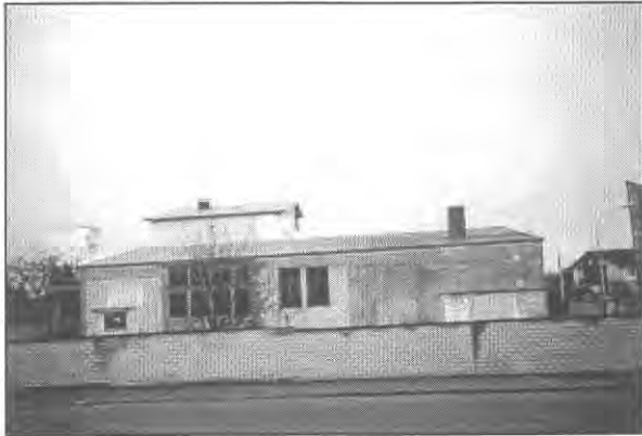
Abb. 8: Das Immobilienkaufobjekt des Moscheevereins, nämlich eine einfache, architektonisch völlig anspruchslose Werkhalle als Baukörper der zukünftigen Moschee
