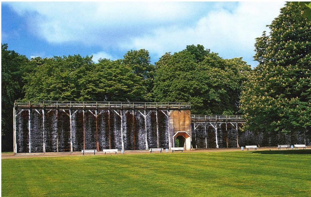
Abb. 2.9. Gradierwerk im Kurpark, diente ursprünglich zur Aufkonzentrierung der Sole und wird heute noch zu Heilzwecken (salzhaltige Luft) weiterbetrieben (Stadtführer Lüneburg).
