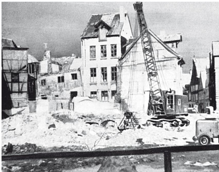
Abb. 3.4. Abbrucharbeiten im Altstadtgebiet nach Senkungsschäden. Foto aus Pleß & Welke (1959).
