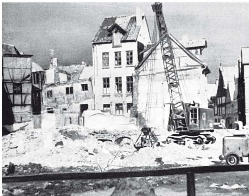
Abb. 3.3: Abbrucharbeiten im Altstadtgebiet nach Senkungsschäden. Foto aus Pleß & Welke (1959).
