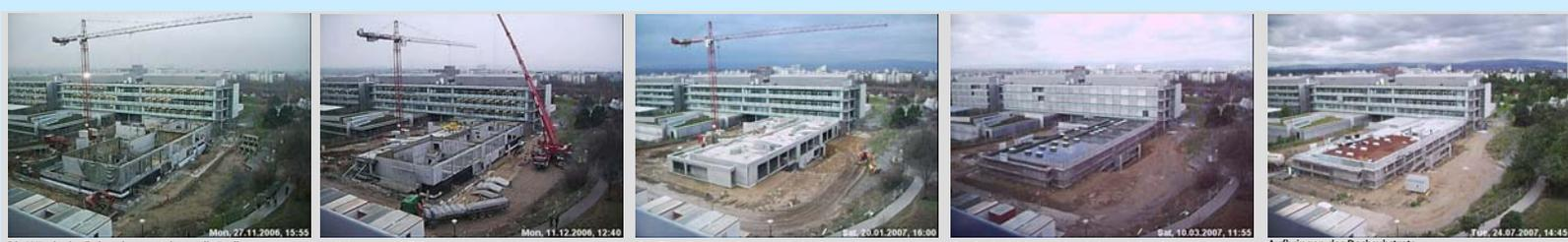
Die Wände des Erdgeschosses stehen vollständig      Anlieferung und Einbau des Hörsaalbodens      Das Zuschütten der Baugrube ist im Wesentlichen abgeschlossen      Das Dach gleicht manchmal einem Swimmingpool, in dem sich die Wolken spiegeln...      Aufbringen des Dachsubstrats
