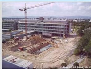
Das Tiefkeller-Fundament (südlicher Teil) wird gegossen
