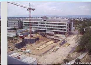
Das Dach des Tiefkellers (südlicher Teil) ist fertig, die entsprechende Baugrube bereits zugeschüttet
