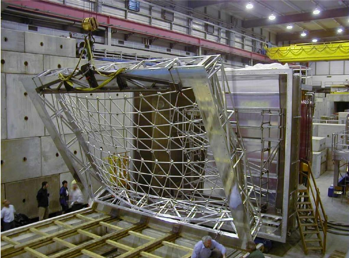
Abbildung 8: Aufrichten der RICH-Rückwand
